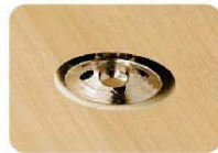
自動消火装置（噴射口）
