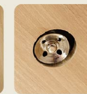
自動消火装置 (噴射口)
